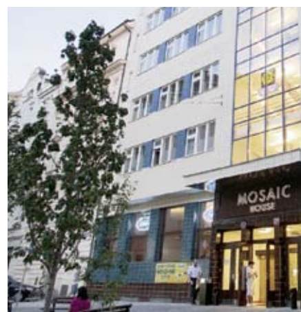
Hostelería. El hotel Mosaic House de Praga está equipado con los sistemas Pontos AquaCycle y Pontos HeatCycle, además de otros productos Hansgrohe.
